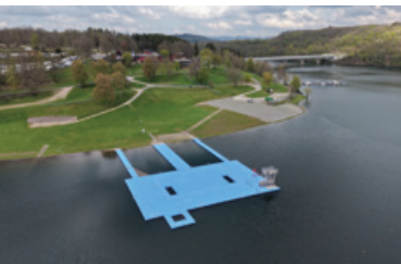
Die Seebühne auf der Bigge misst 36 mal 16 Meter und ist mit 55 Tonnen Ballast gesichert. Das Herzstück des Biggesees Open Air dient bei der AvD-Röhr-Klassik als Grillstation
